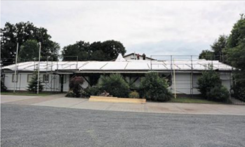
Das Dach des Schützenhauses in Kastl erhält ein neues Trapezdach mit PV-Anlage zur Eigenstromgewinnung. Die Hubertus-Schützen übernehmen die meisten Arbeiten in Eigenleistung.
