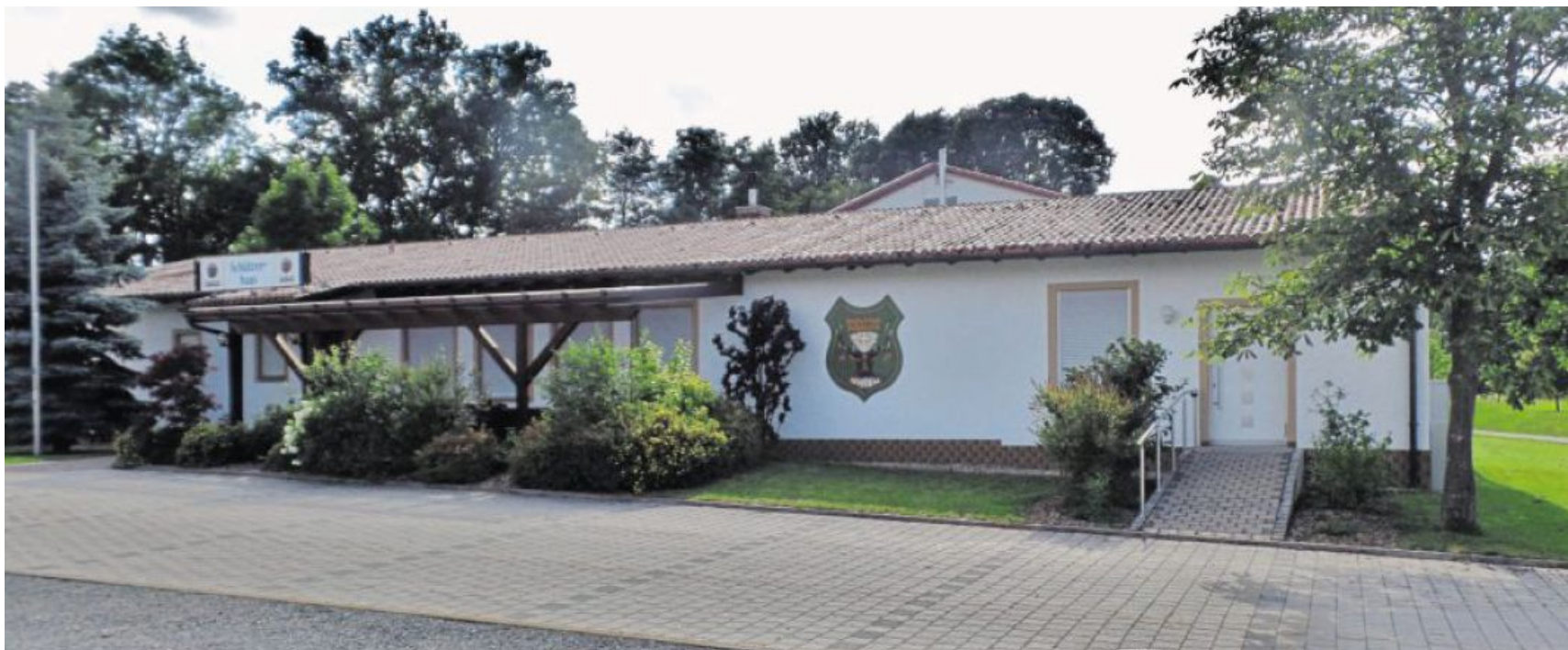
Die Sportschützen „Einigkeit Hubertus“ kehren mit der Aufnahme des Trainingsbetriebes für den Schießsport sowie der Öffnung der Außenterrasse und der Bewirtung im Innenbereich in ihrem Schützenheim (unser Bild) stückchenweise zurück zur Normalität.
